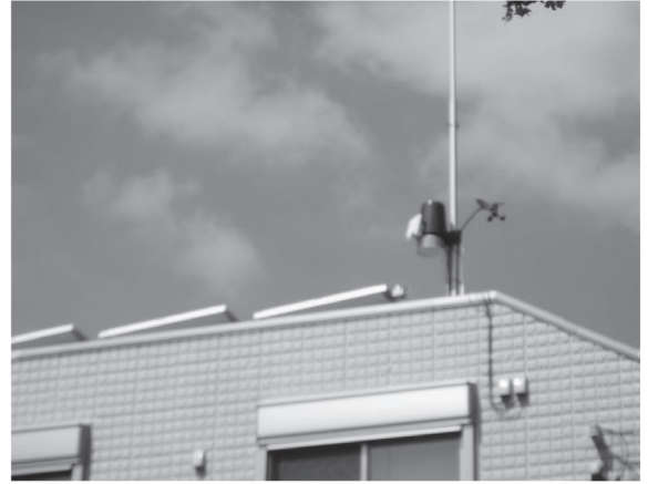
Fig. 7 環境センサーの取り付け状態
